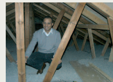
Romuald a choisi la pose d'un lit de cellulose sur le sol du grenier.
